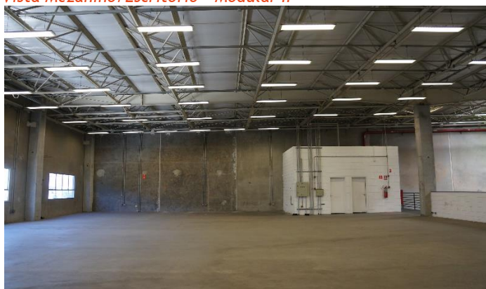
Vista Mezanino/Escritório - Modular II
