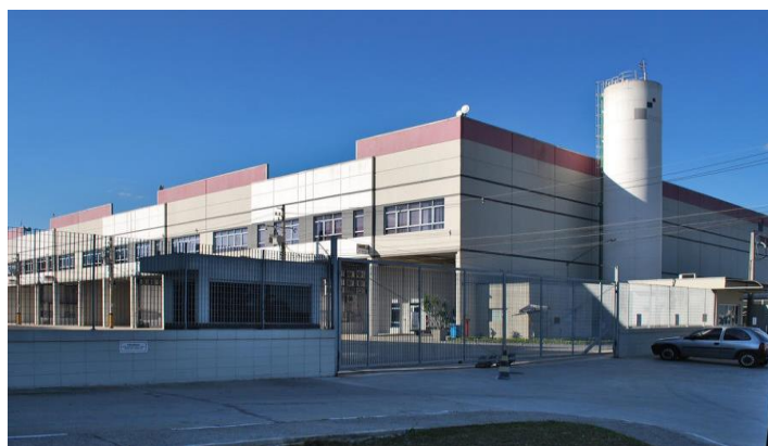
Fachada Modular II
